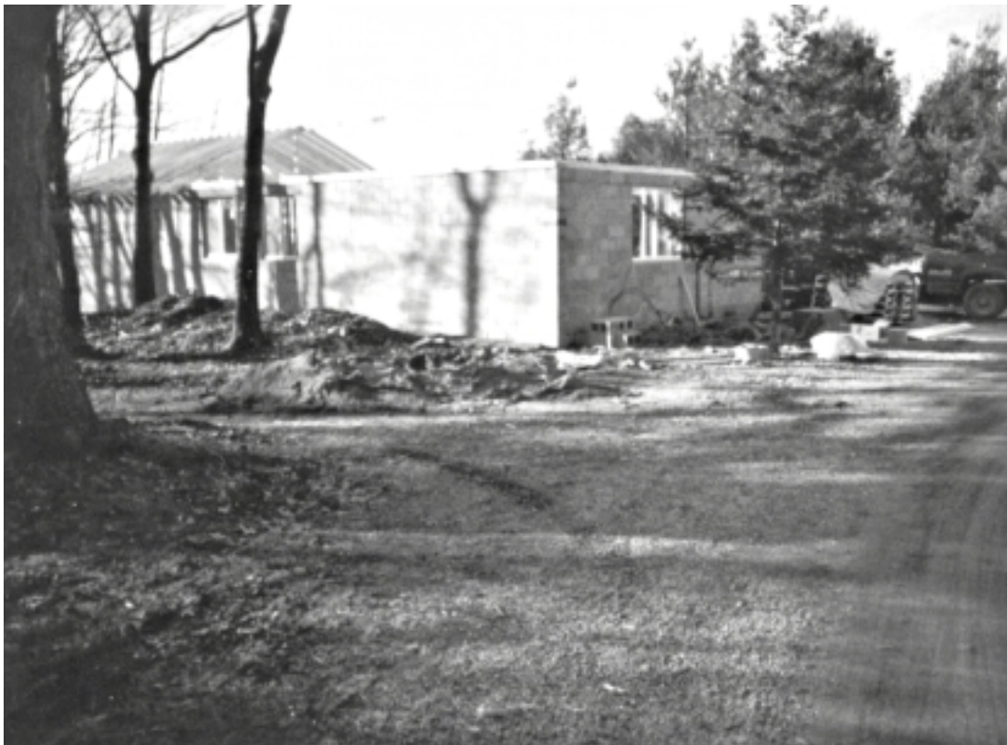
Az új konyha építése (1999 november)
